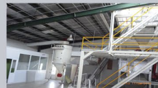
آرتا نوفرآور پارت تاریخ احداث پروژه : سال ۹۴ محل احداث : مشهد
